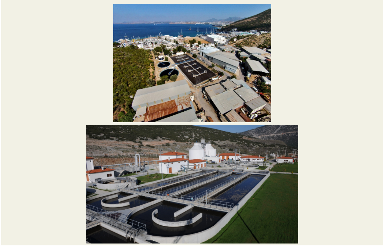
Şekil 13: Muğla Konvansiyonel Atık Su İşleme Tesisleri
